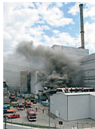
Brand im Kernkraftwerk Krümmel, Sommer 2007
