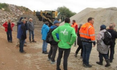
Johann Meindorfer organisierte (Okt. 2025) Besichtigung einer Baustoff-Recycling-Anlage, Nähe Straubing
