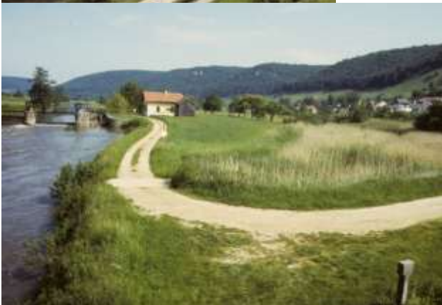
Deising, bei Schleuse 11 des Ludwigskanals, 1. Juni 1983, Bildautor Karlheinz Heinlein
