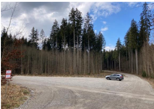
Abbildung 2: Überdimensionierte Kreuzungen nach dem Bau der Windkraftanlage
