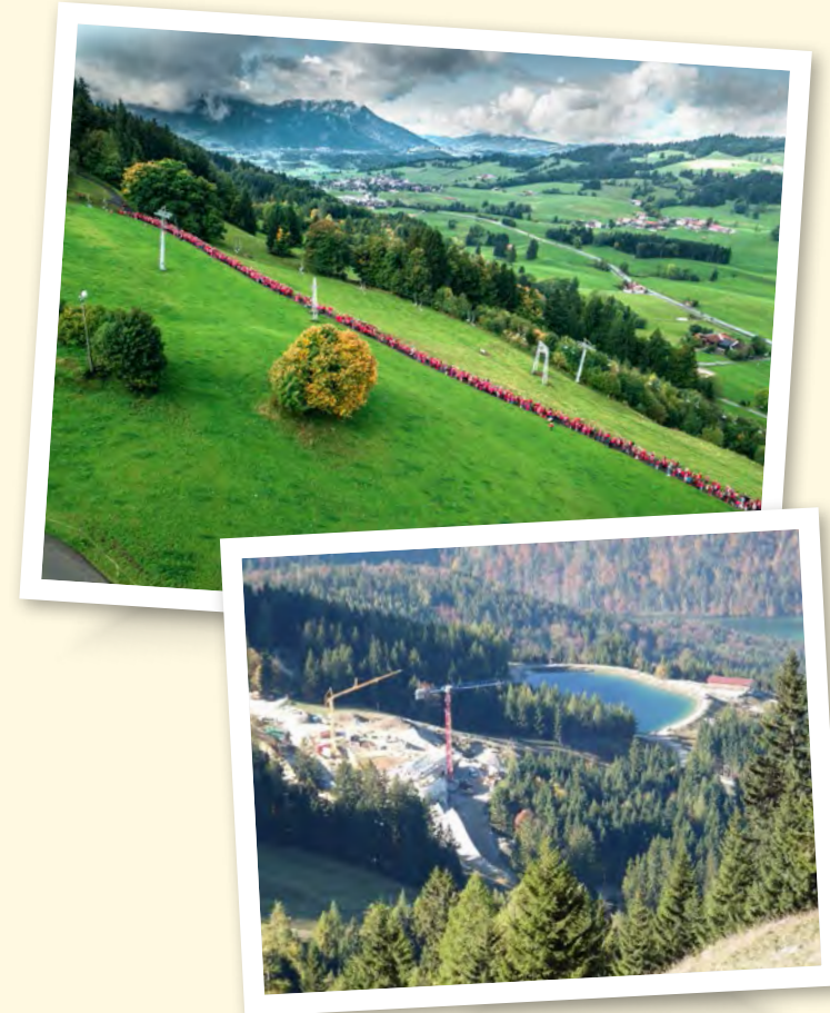
Ausbau der Jennerbahn im Berchtesgadener Land
