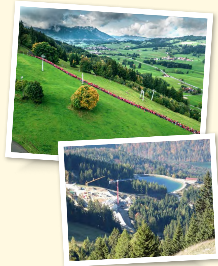
Ausbau der Jennerbahn im Berchtesgadener Land
