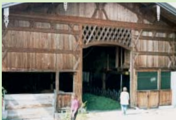
Neuer Stadel mit altem Bundwerk – im Eigenbau errichtet von der Familie Kurfer in Wilperring/Söchtenau. (Foto: BN Rosenheim)
