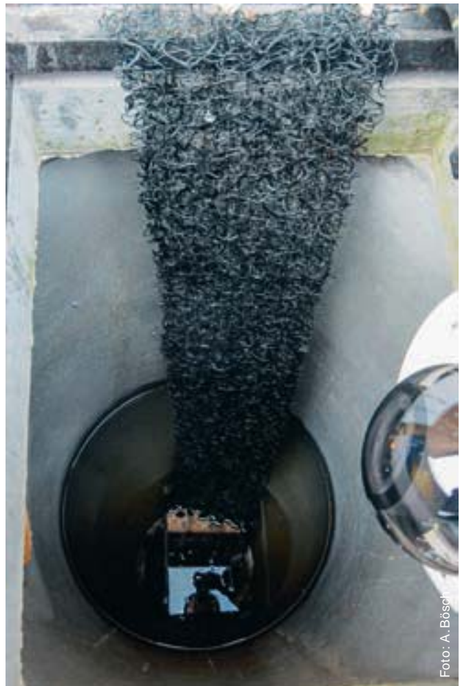
Bei der Untersuchung verschiedener Ausstiegssysteme schloss die Drainagematte Sytec Terramat am besten ab. Sie wird in den Schacht gehängt, mit etwas Ballast versehen – damit kein Überhang entsteht – und oben zwischen Rost und Rahmen eingeklemmt.
