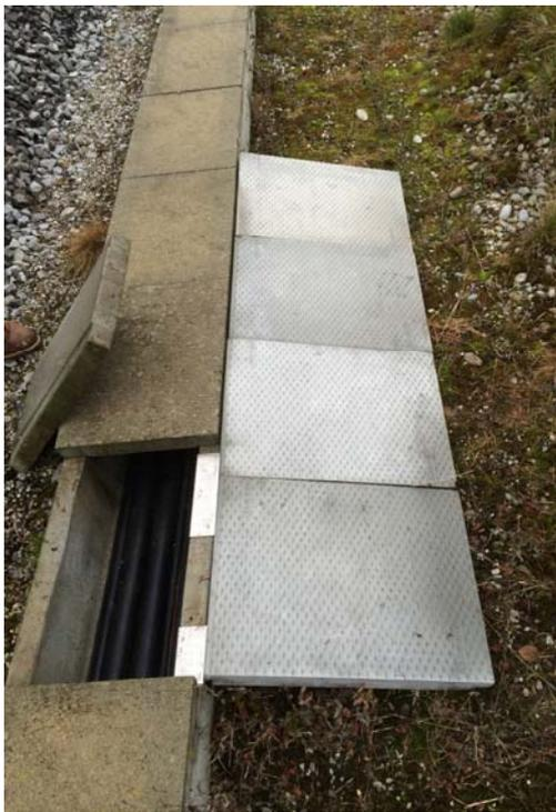
Abbildung 18: Rampen bei Grafenried, Deckel des Kabelkanals geöffnet; im Kabelkanal sichtbar sind die Kabel.
