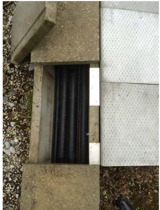
Abbildung 19: Rampen bei Grafenried; Detailansicht der INOX-Klammern bei geöffnetem Kabelkanal.
