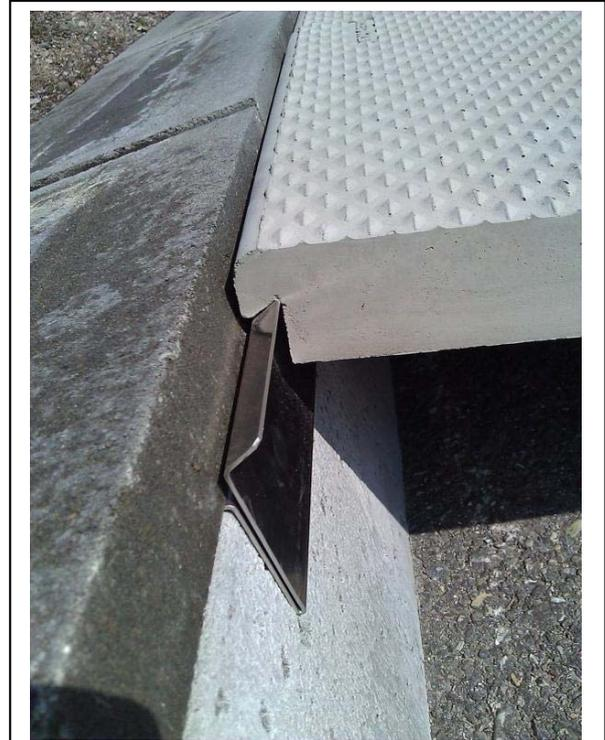
Abbildung 15: Detailansicht der Klammer mit eingehängter Rampe.
