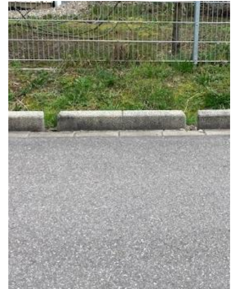
Randstein mit Durchlässen
