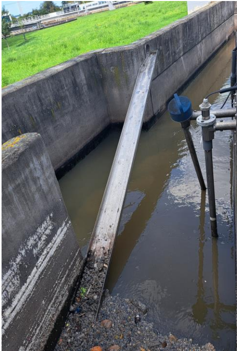
Innere Rampe: Blech
