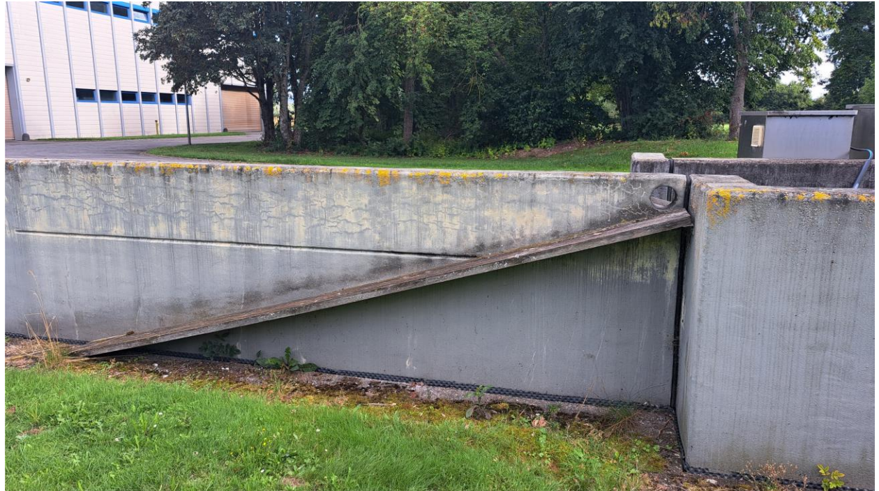
Äußere Rampe: Holz
