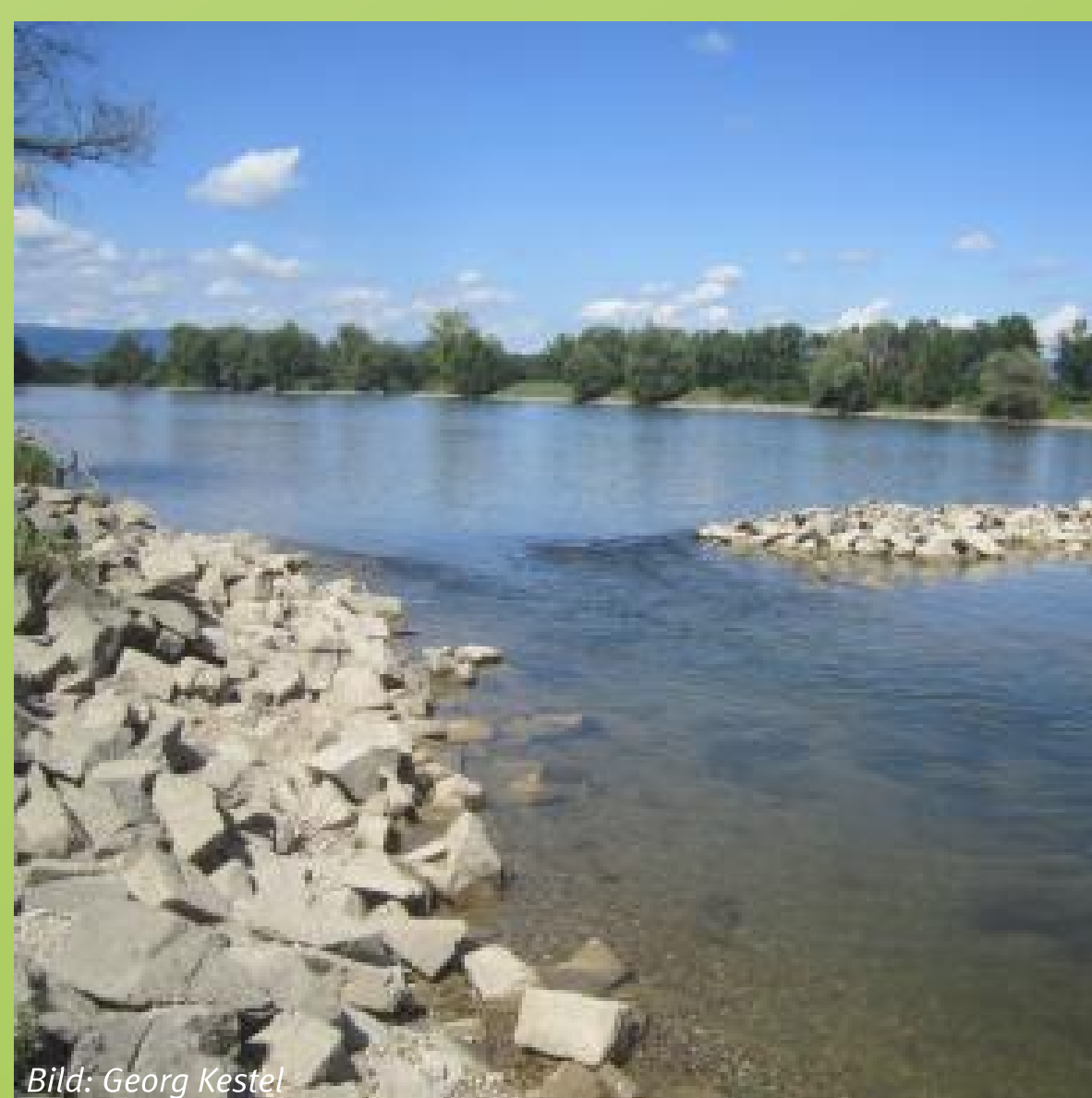
Bild: Georg Kestel Schon mit einer schmalen Absenkung der Buhne an der Landseite wird die Durchströmung des Buhnenfeldes erheblich verbessert.
