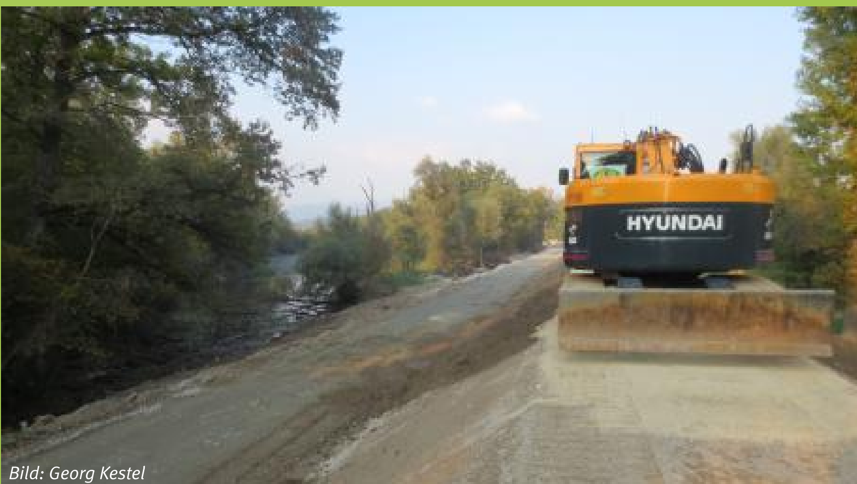
Wiederherstellung des gebrochenen Isardeiches bei Altholz-Fischerdorf. Seit Jahrzehnten ist bekannt, dass die Deiche zwischen Straubing und Vilshofen auf langer Strecke etwa einen Meter zu niedrig sind. Vielfach entsprechen sie, da sie keine Innendeichung aufweisen, auch nicht dem heutigen Stand der Technik.
