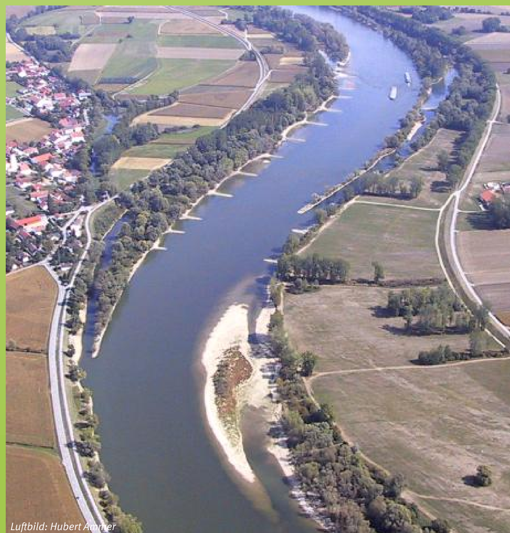
Luftbild: Hubert Ammer Flussregulierung bei Aicha: links Buhnen, rechts oben Parallel-Leitwerke; die Insel im Bildvordergrund kann als Vorbild für die ökologisch optimierte Ausgestaltung von Flussbauwerken dienen.
